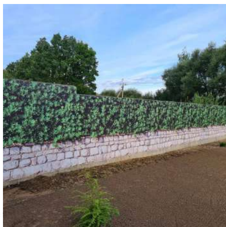
5. На бетонный забор
